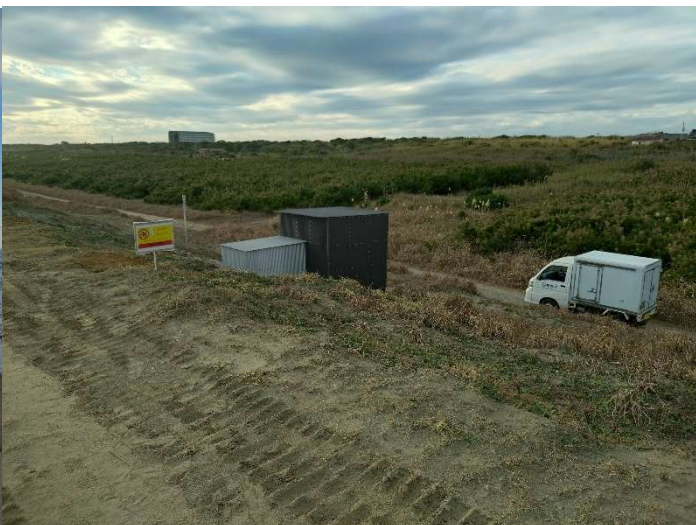
海水送水のポンプ小屋
