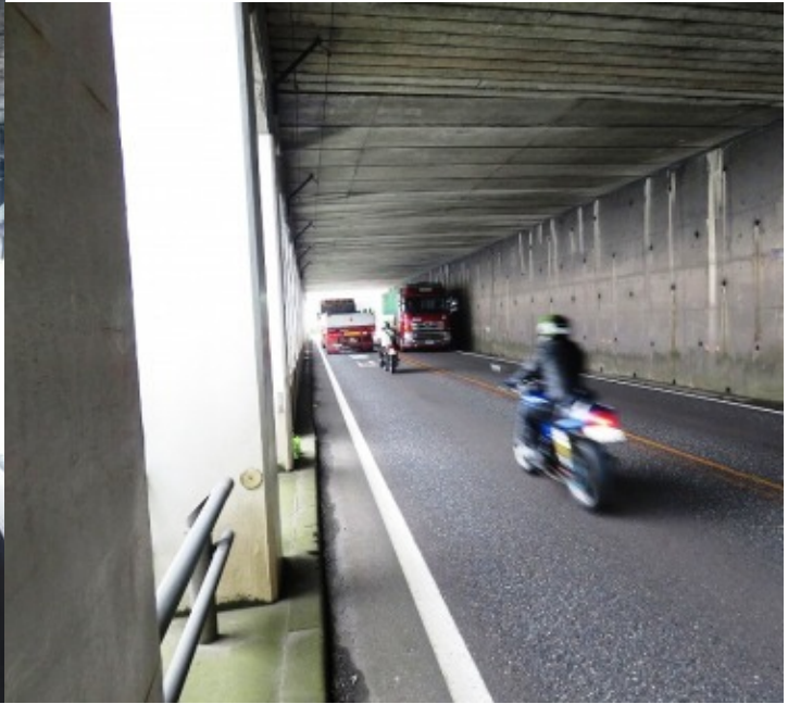
洞門内部から東方向を見る
