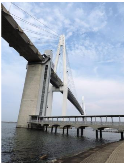
富山新港大橋(橋脚の右端がエレベータ)
