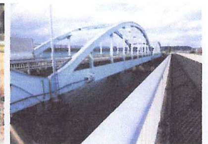
日向大橋／歩道 ↑
