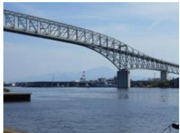
境水道大橋と遠方に大山を望む
