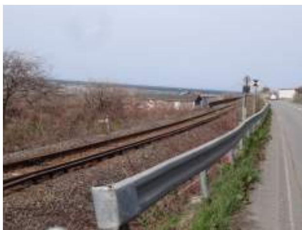
海岸・線路・国道
